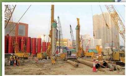
使用隔音屏及吸音罩以減噪音及塵埃
