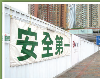
在工地裝上圍板以隔噪音及灰塵
