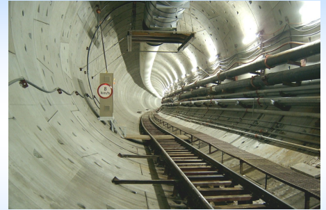
建造中的隧道
