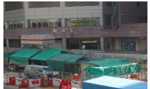
為可能發出較大聲響的機組裝上隔音屏障
