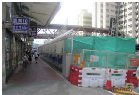
工地以圍板圍起以阻塵埃及聲浪
