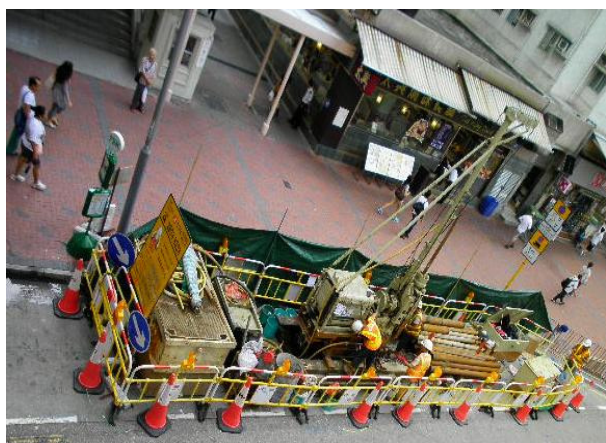
早前於海泓道進行詳細土質勘察工程
