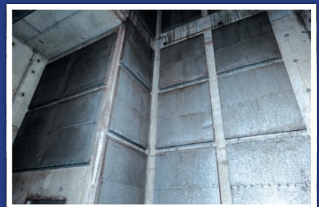
通風樓內裝設隔音綿
