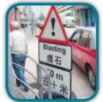
▲ 鑽爆工程位置通告指示牌
