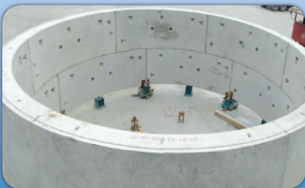
▲由預製組件裝嵌成的隧道壁
