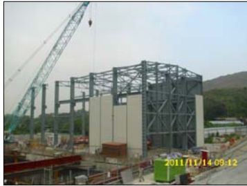
隔音罩建造中
