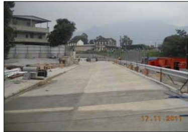
為配合封閉橫台山散村路之臨時道路
