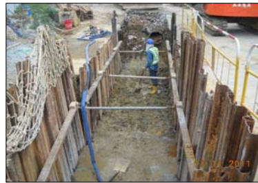
渠道工程進行中
