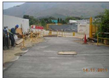
重鋪現有路面
