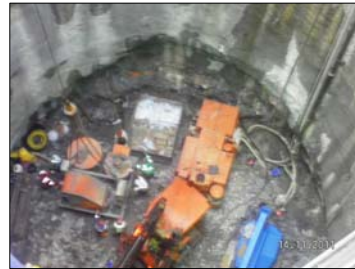
輔助豎井建造中
